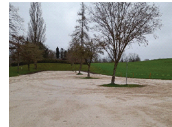
Sanierung der Parkplatzfläche am Chiemseering
