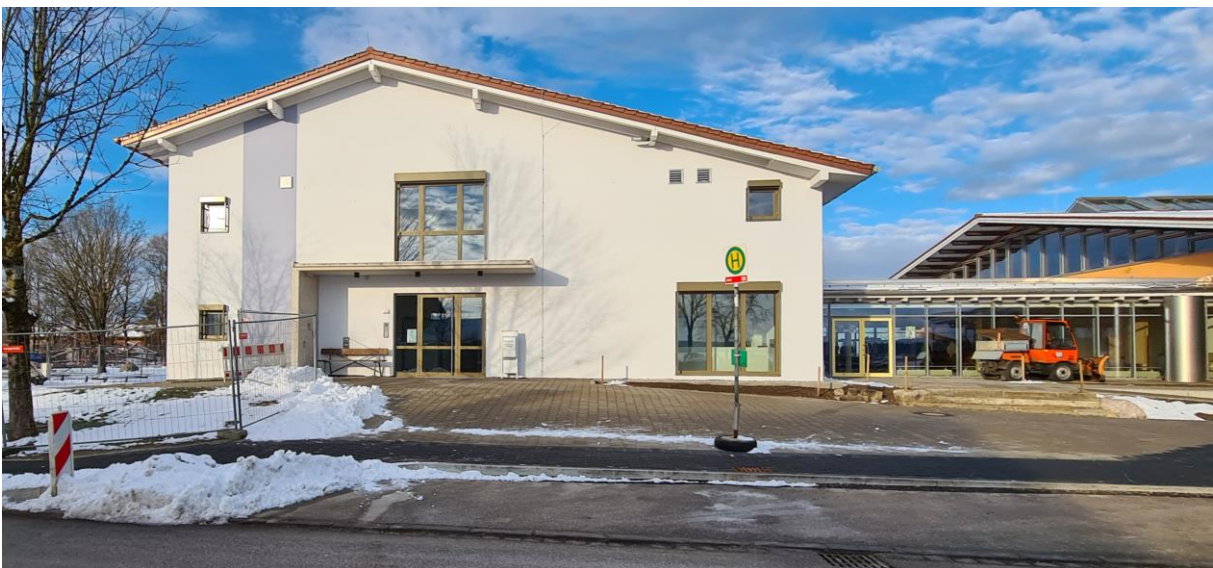
Neues Ost-Treppenhaus mit Aufzugsanlage
