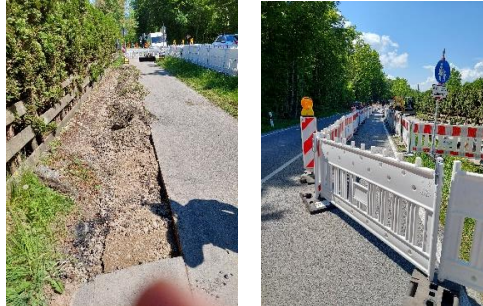
Asphaltreparatur am Fuß-/Radweg Grabenstätter Str.
