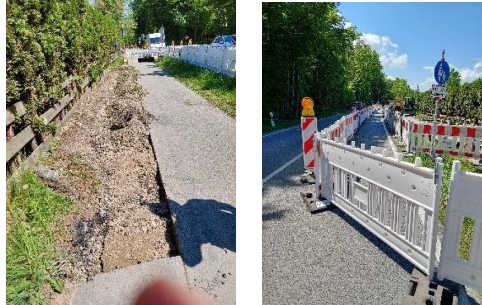
Asphaltreparatur am Fuß-/Radweg Grabenstätter Str.
