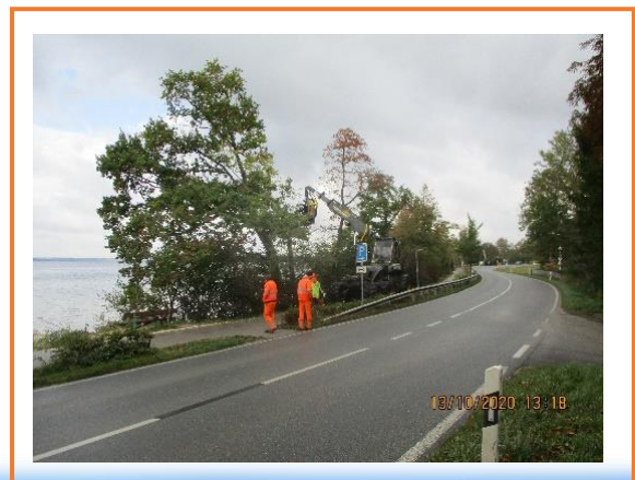
Baumfällarbeiten an der Grabenstätter Str.
